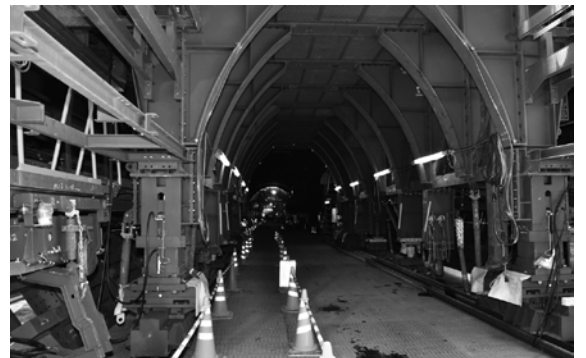
工事が進む羽沢トンネル
